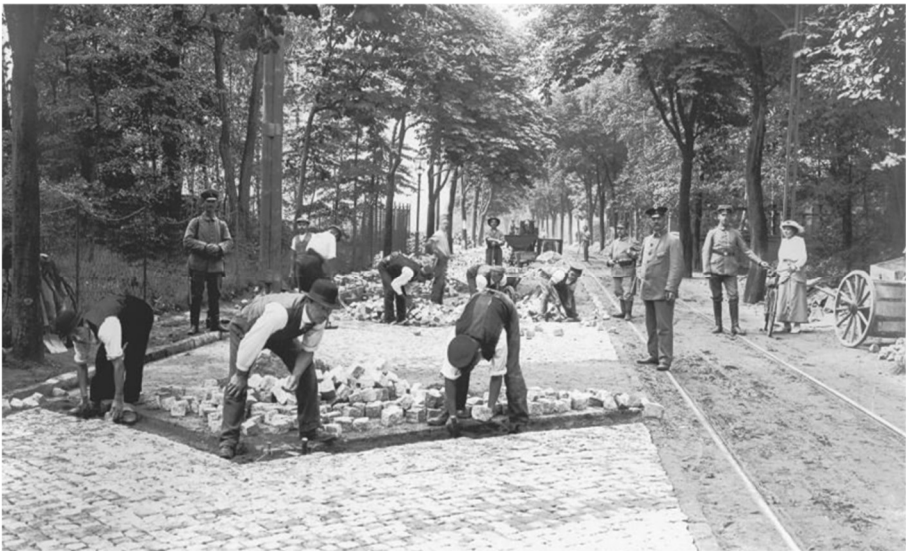
Straßenbau – Pflasterarbeiter an der Lichterfelder Allee
