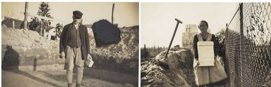
Oskar Pollner und seine Frau Emma 1932 beim Hausbau in der Alsterstr. 7 in Teltow.
