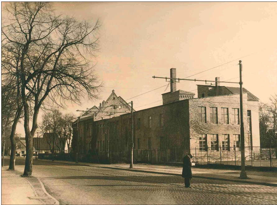
Das Schulgebäude mit Notdach
