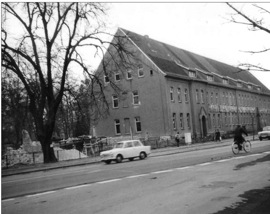
Das Schulhaus Anfang der 1980er Jahre vor Errichtung des Anbaus mit Hausmeisterwohnung Foto: G. Duwe
