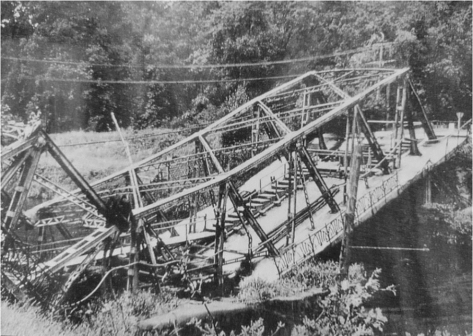
Fotografie der zerstörten Knesebeckbrücke 1945, Sammlung Heimatverein Teltow
