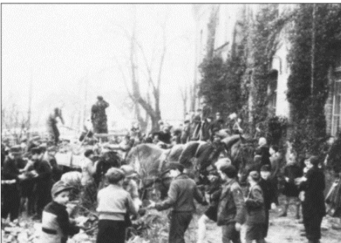
Aufräumarbeiten an der Stadtschule nach Pfingsten 1945 Sammlung Heimatverein Teltow
